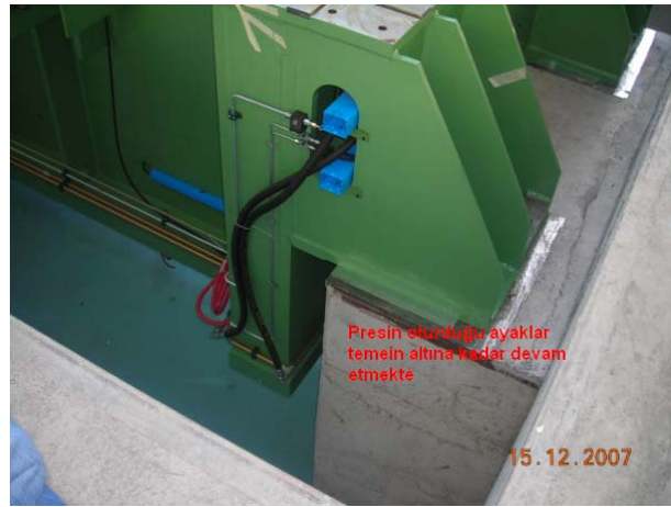
Şekil 3. Presin temel içine yerleştirilmesi
