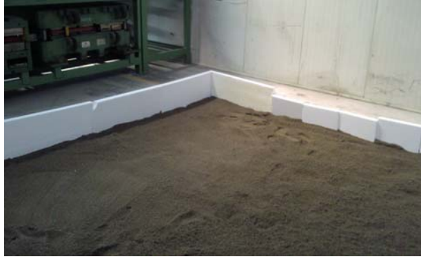
Şekil 2. Pres temeli ile fabrika temeli ayrımı
